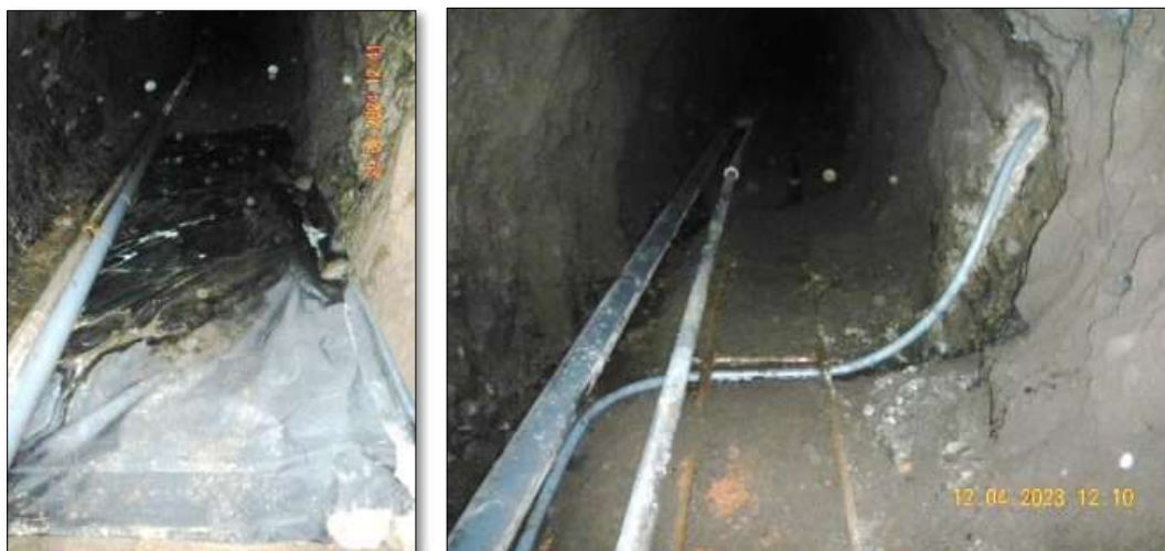
Imagen 12. Láminas plásticas en solera (izqda.) y catas con tubería flexible
